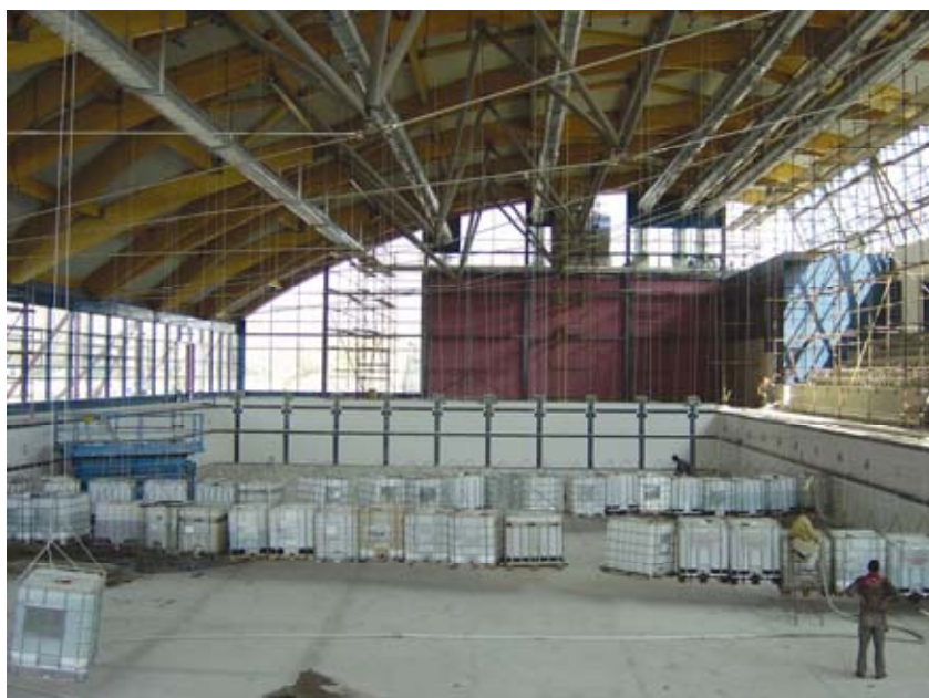
Slika 9. Ispitivanje krova bazena u Utrinama
