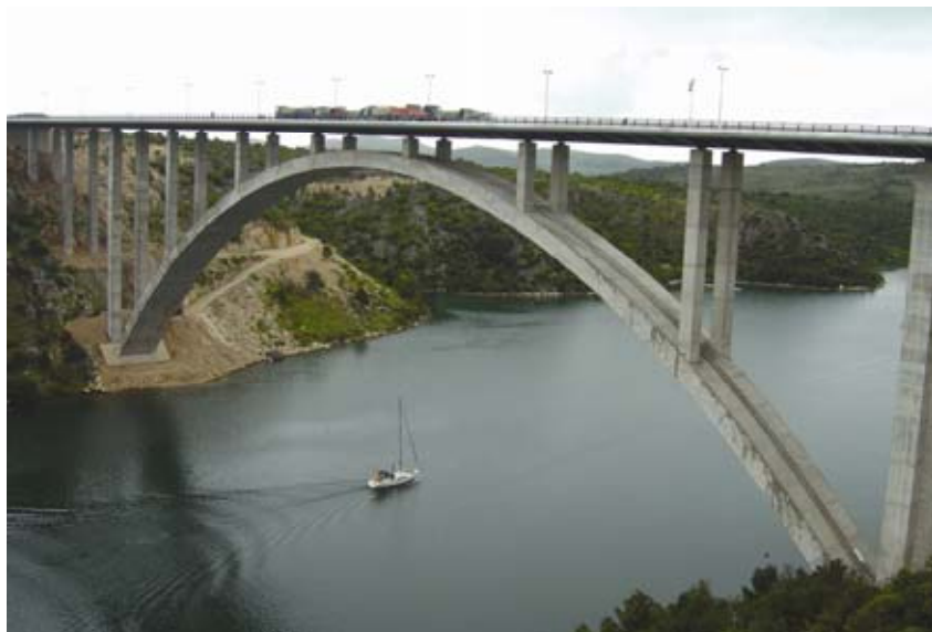
Slika 10. Ispitivanje mosta Krka kod Skradina
